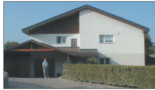
Zufriedener Besitzer vor seinem Haus in Muolen: Heizkessel ersetzt durch Sanierungswärmepumpe.
