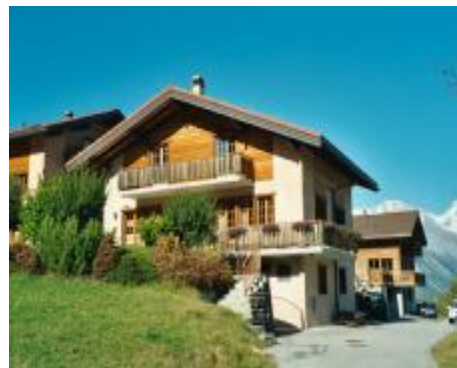
Le chalet à Haute Nendaz VS : Le chauffage électrique directe a été remplacé par une pompe à chaleur Turbo.
