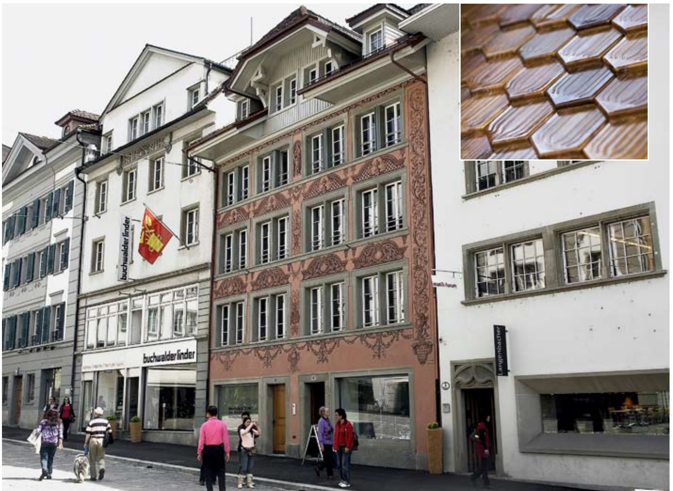
Ein 500 Jahre altes Haus in Luzern wurde fit für die Zukunft gemacht: mit wärmeaktiven Dachziegeln (kleines Foto) als Energiequelle für die im Kellergeschoss platzierte Wärmepumpe, die mit einer speziellen Steuer- und Regelungstechnik optimiert betrieben wird. Foto Bildarchiv ewl
