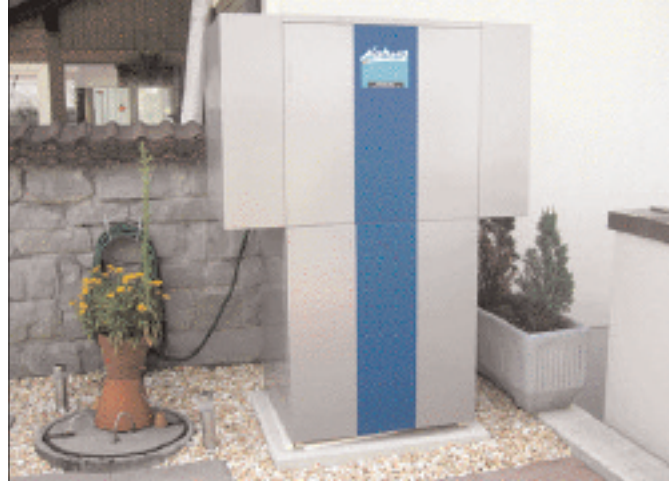
Image 8: Pompe à chaleur électronique air/eau installée à l'extérieur avec une modulation de puissance de 3-9 kW.
